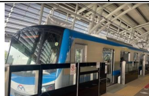
地下鉄建設には日本のODAを活用。日系企業も交通インフラ整備を支援した。
