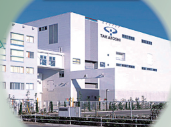
建設混合廃棄物リサイクル施設 高俊興業(株)
