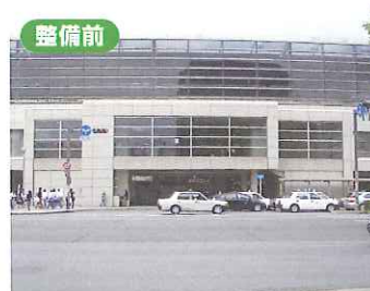
整備前 景観的魅力の乏しい駅正面
