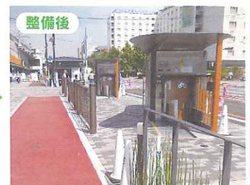
整備後 地下を有効活用したコンパクトな機械式駐輪場
