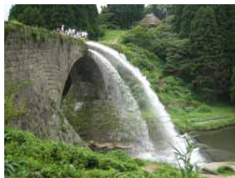
通潤橋と放水
